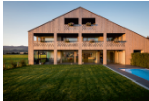
Wohnhaus, Benken Minergie-A und Minergie-P
